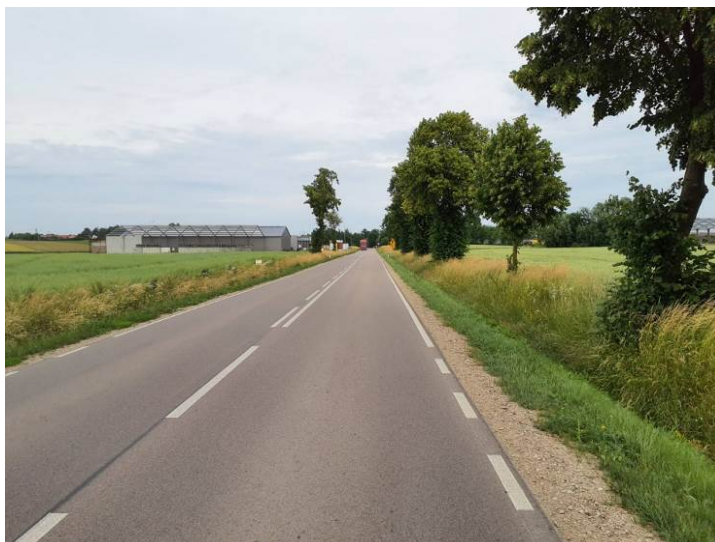
Fot. 12. Koniec przeznaczonego do rozbudowy fragmentu DK63 w okolicy wsi Czyżew-Złote Jabłko
