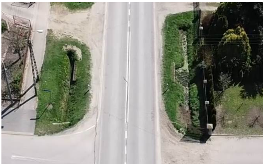
Fot. 5. Istniejący przepust drogowy P-3
