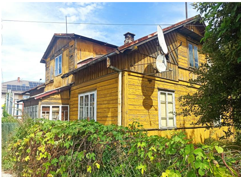
Budynek nr 2 przewidziany do rozbiórki
