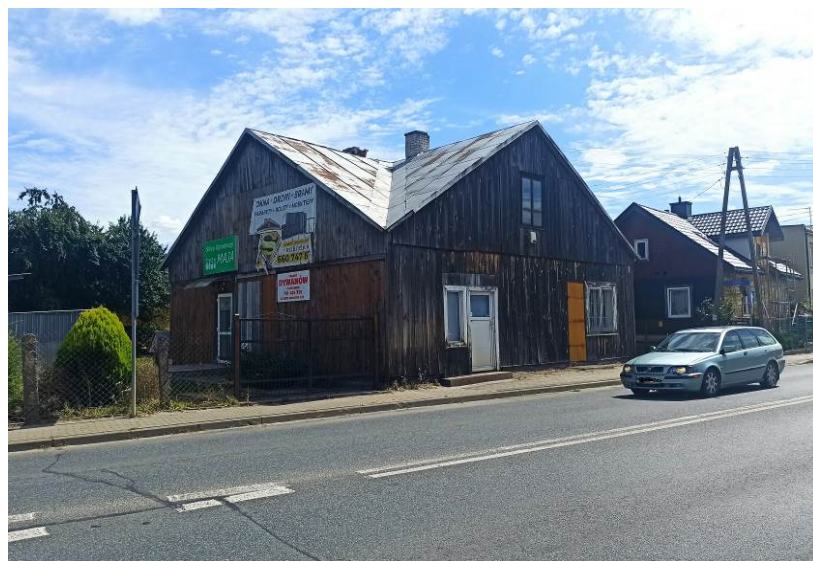
Budynek nr 1 przewidziany do rozbiórki
