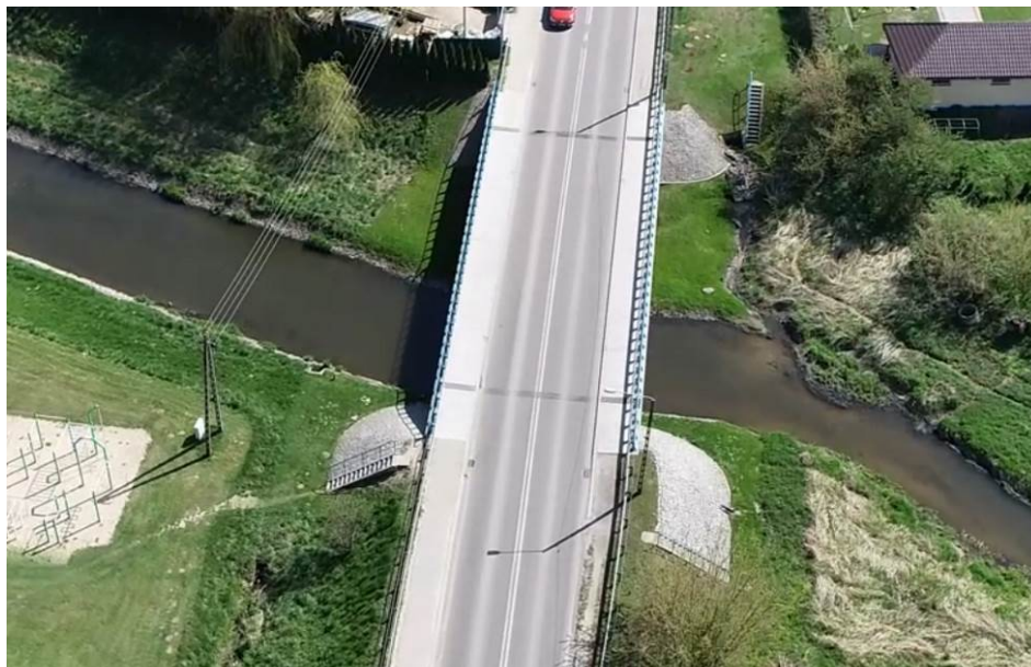
Fot. 1. Istniejący most na rzece Brok
