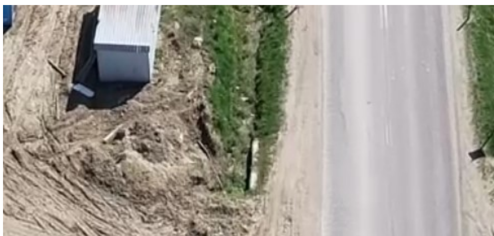
Fot. 7. Istniejący przepust drogowy P-5
