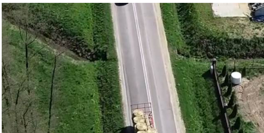
Fot. 4. Istniejący przepust drogowy P-2
