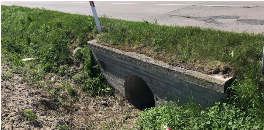
Fot. 5. Istniejący przepust drogowy P-2
