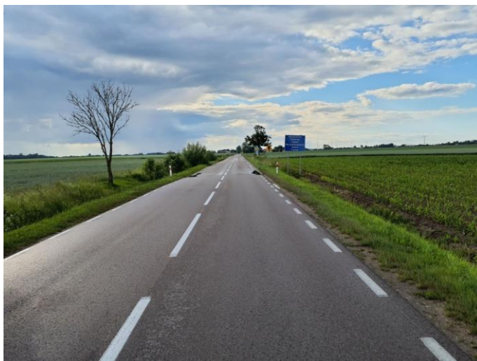
Ryc. 5. Koniec przeznaczanego do remontu fragmentu DW 690 w okolicy wsi Stokowo-Szerszenie
