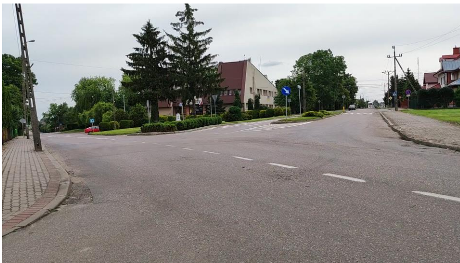
Fot. 1. Skrzyżowanie z drogą powiatową 2072B
