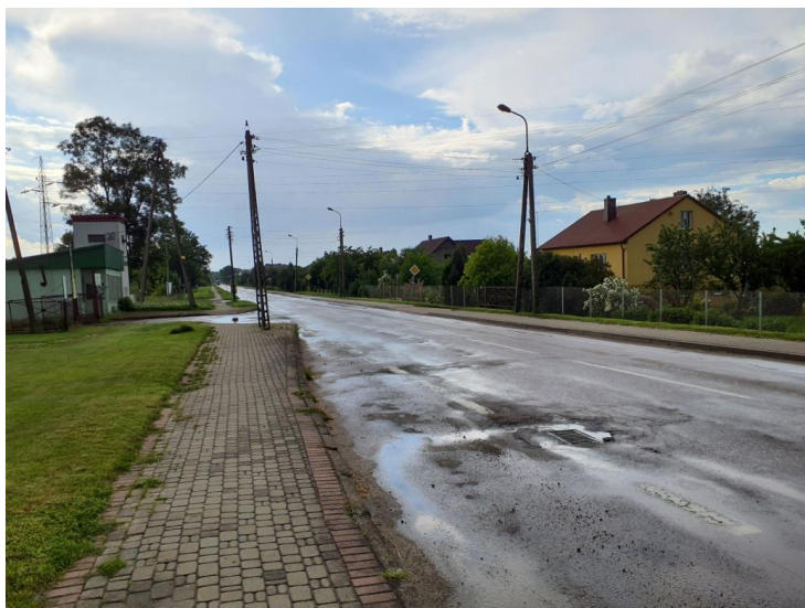
Ryc. 3. Przeznaczona do remontu ulica Szkolna/DW 690 w okolicy miejsca połączenia z wiaduktem nad linią kolejową.
