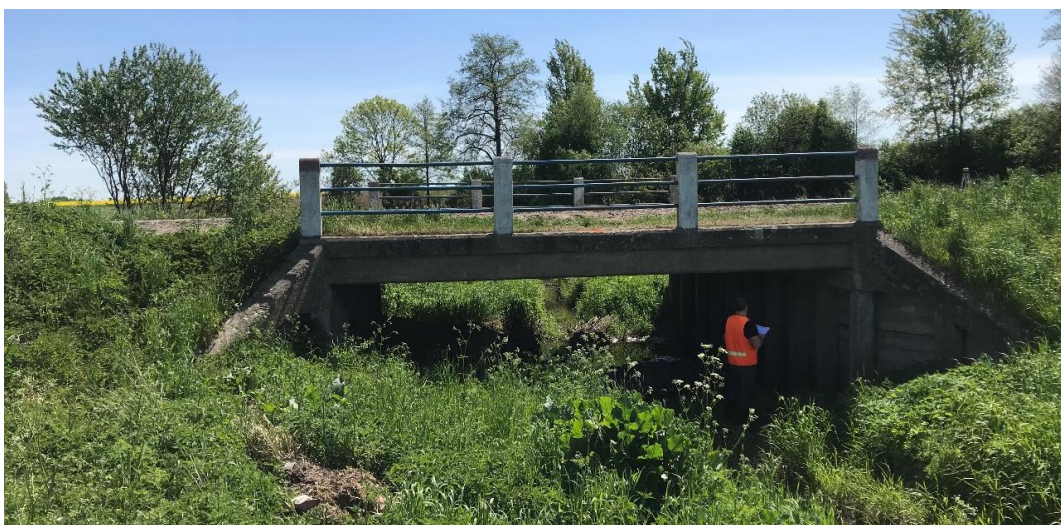
Fot. 4. Istniejący most na rzece Siennica
