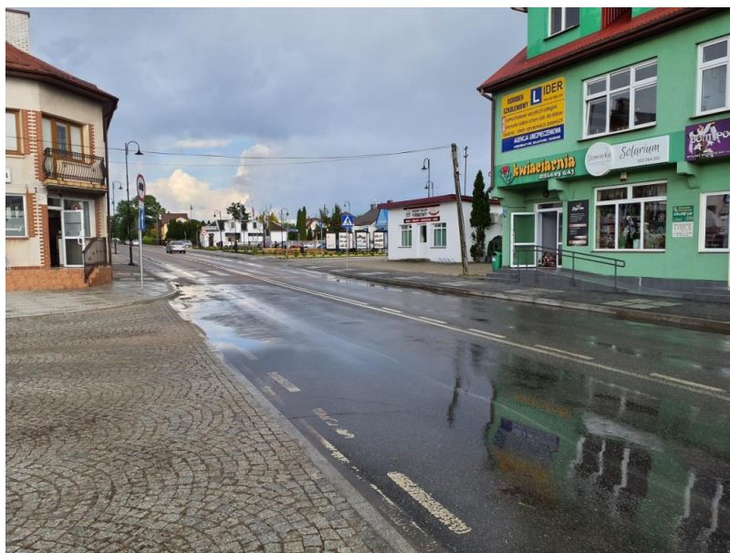
Fot. 7. Przeznaczona do remontu ulica Mazowiecka/DW 690 przy rondzie Jana Pawła II
