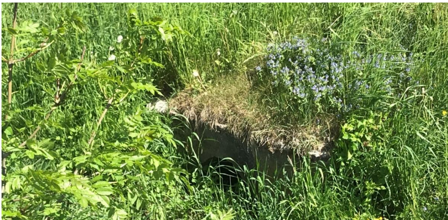
Fot. 6. Istniejący przepust drogowy L-3
