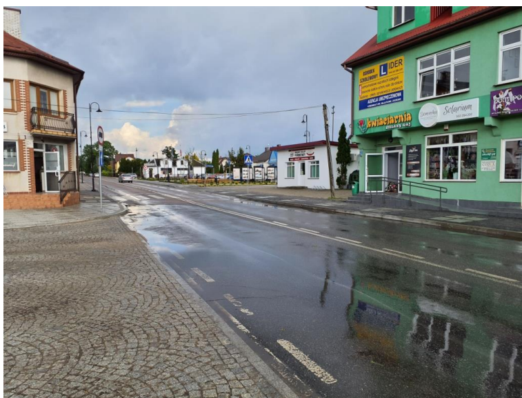
Ryc. 2. Przeznaczona do remontu ulica Mazowiecka/DW 690 przy rondzie Jana Pawła
